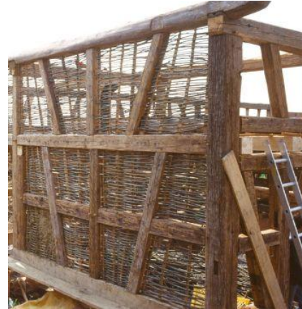
Abb 4 Fachwerkkonstruktion, Foto: Haeuserauslehm.de
