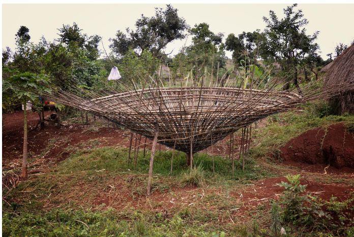
Abb 8: Herstellung eines geflochtenen Daches Foto: Wikipedia
